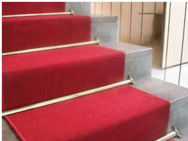
Perfiles para su uso en la fijación de pasillos de escaleras. Tubos de latón y aluminio triangulares, aplicables con soportes fijos o que se pueden abrir para facilitar la limpieza de los pasillos STR13.
